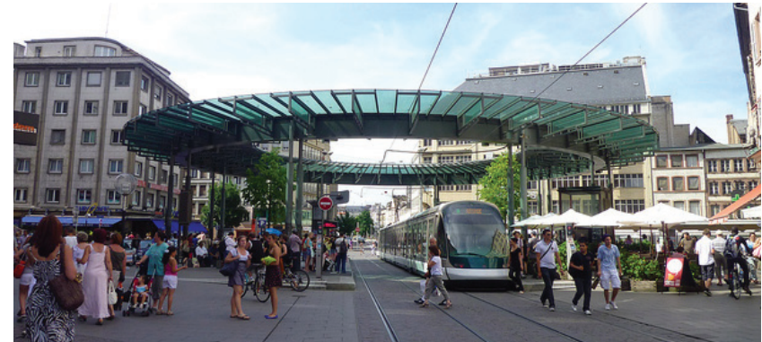
Referentie: Stedelijk OV knooppunt en hoogwaardige tramhalte in Straatburg Référencé: Jonction urbaine des transport publics et un arrêt de tram de qualité à Strasbourg
